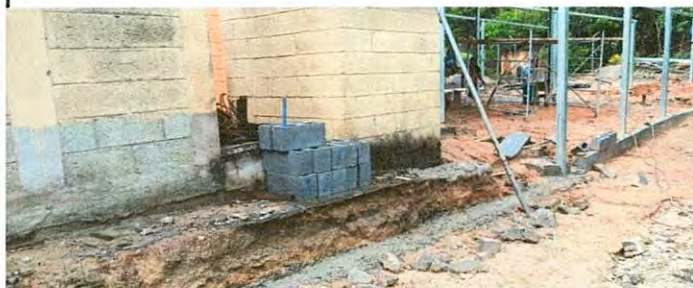
Foto 1: Reparación de muro perimetral por hundimiento
