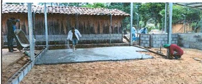
Foto 2: Reparación y cambio de losa de patio
